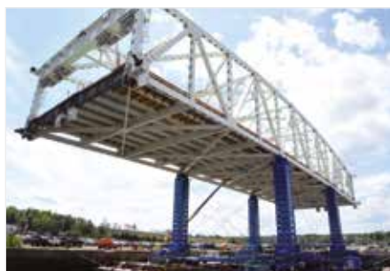
Krokové zdvihání mostu
