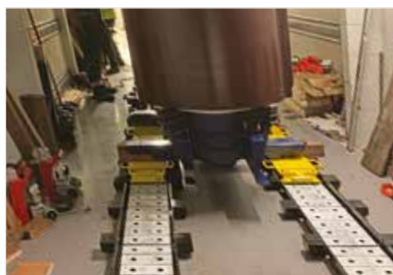
Přeprava rotoru turbíny.
