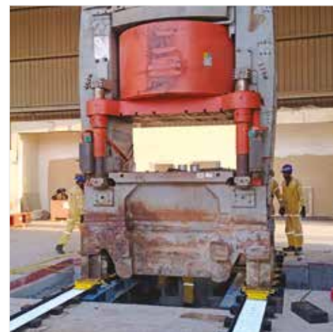
▲ Ližinový systém při odstraňování starého lisu z továrny, aby se uvolnilo místo novému.
