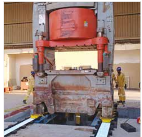
▲ El sistema de deslizamiento se utiliza para retirar una prensa vieja de una instalación para hacer espacio para el nuevo equipo.
