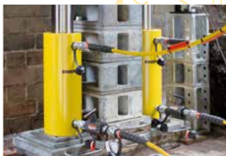
Elevación y lanzamiento de puentes
