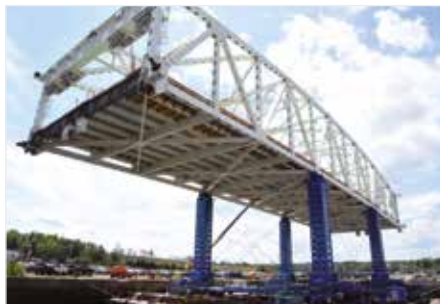
Elevación incremental de puentes
