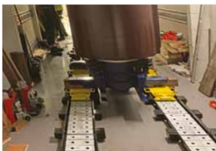
Transport rotor turbină
