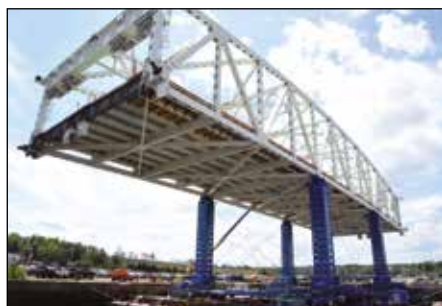
Ступенчатый подъем секций мостов
