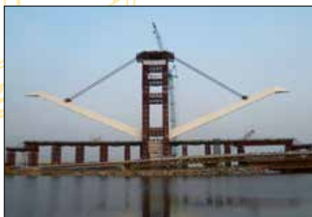
Высокоточный подъем тяжелых конструкций с использованием домкратов
