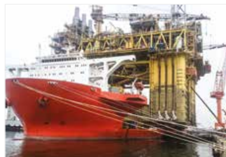
Synkron superlyftning och lansering
