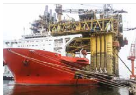
Super-levage et pose synchronisés
