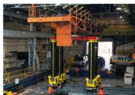
Déplacement de machines
