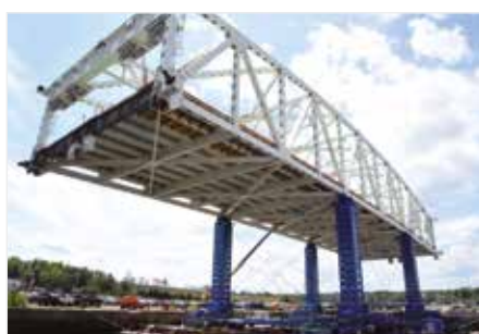
Levage progressif de pont
