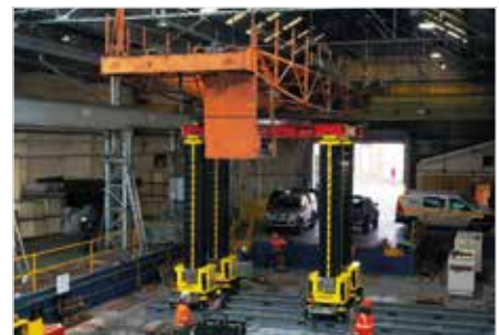
Verplaatsen van zeer machines
