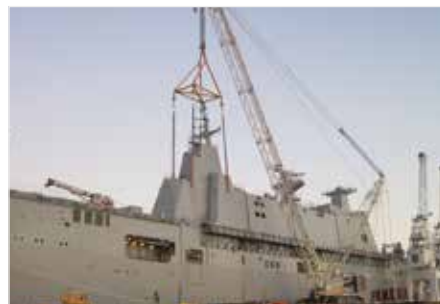
Synkronisert heising og posisjonering av last
