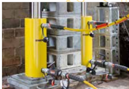
Løfting og fremføring av broer
