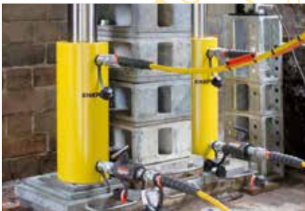
Brückenhub und -vorschub
