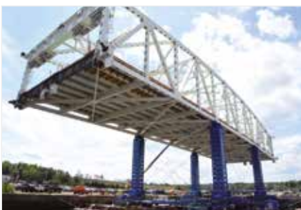
Stufenweiser Brückenhub
