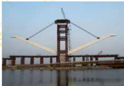
Anheben mit Hochpräzisionssteuerung
