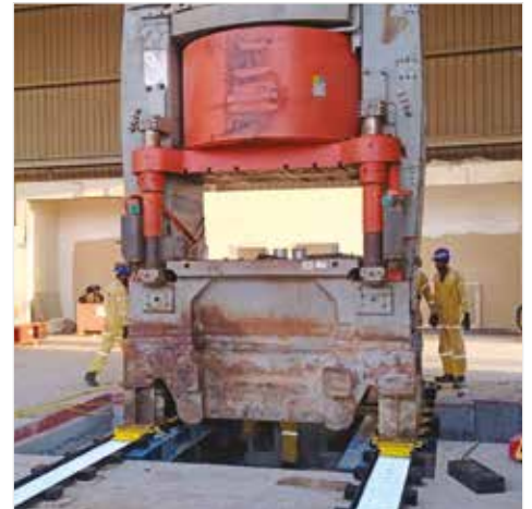
▲ Alustaa käytetään poistamaan vanha puristin, jotta saadaan tilaa uudelle laitteelle.
