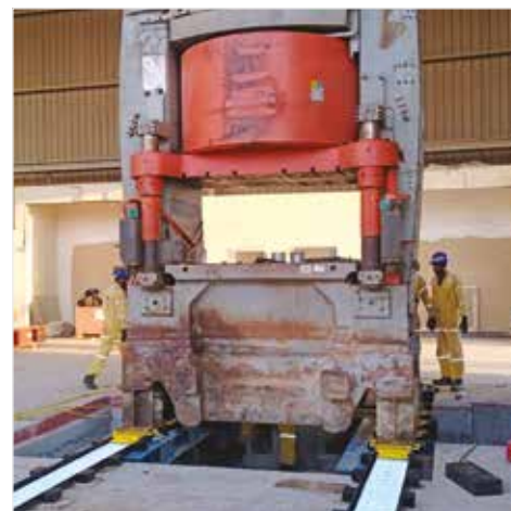
▲ Sistemas de esquadagem usado para remover uma prensa antiga de uma instalação para abrir espaço para um novo equipamento.
