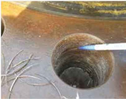
▲ Una rosca típica antes de la reparación
