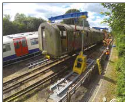
Retirada de trenes de desmantelamiento del metro de Londres con un pórtico hidráulico
