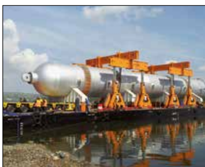
Descarga de un hidrocrackeador de 1300 toneladas
