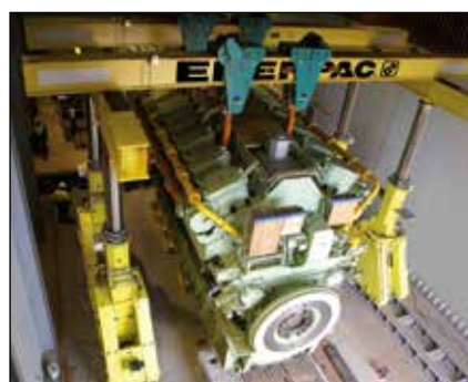
Instalación de un generador en la central eléctrica de Owen Springs
