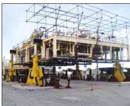
Montaje de un módulo de una plataforma petrolífera
