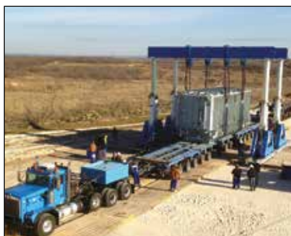
Instalación de un transformador con un pórtico hidráulico
