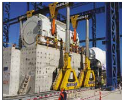
Instalación de turbinas y generadores en una nueva central eléctrica en Libia
