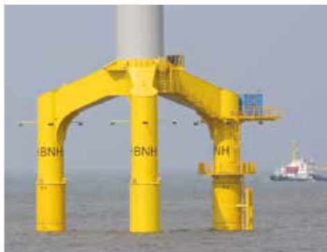
▲ Nivelamento de turbinas eólicas offshore: o sistema de levantamento sincronizado de Enerpac forneceu a solução de nivelamento das peças transversais de apoio para 80 turbinas eólicas.
