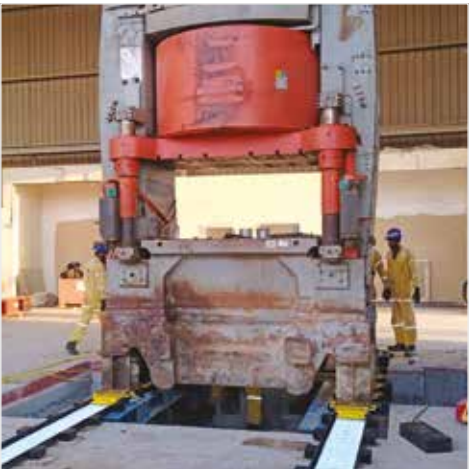
▲ El sistema de deslizamiento se utiliza para retirar una prensa vieja de una instalación para hacer espacio para el nuevo equipo.
