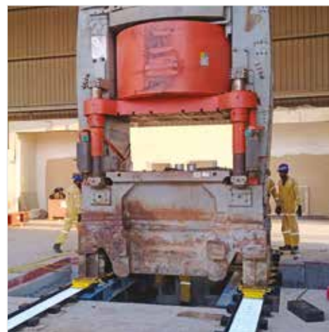
▲ Système de ripage faible hauteur utilisé pour retirer une ancienne presse d'un site afin de faire de la place pour de nouveaux équipements.
