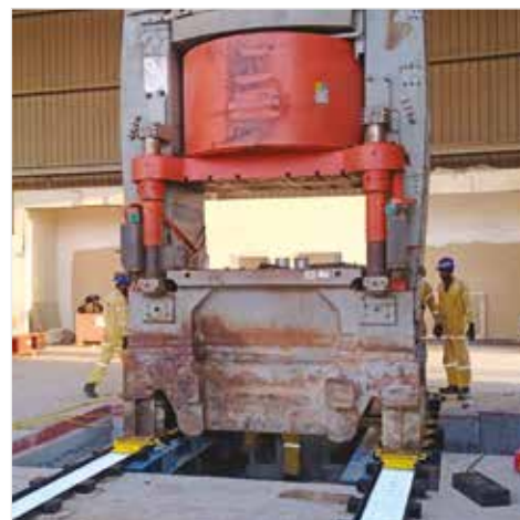
▲ Sistema di scorrimento utilizzato per rimuovere una vecchia pressa da un impianto per fare spazio a nuove attrezzature.
