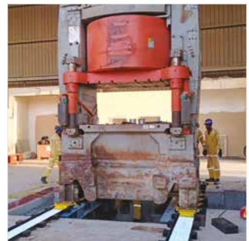
▲ Sistemas de esquadagem usado para remover uma prensa antiga de uma instalação para abrir espaço para um novo equipamento.
