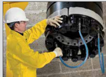
▲ Aplicación del tensado de múltiples tornillos.
