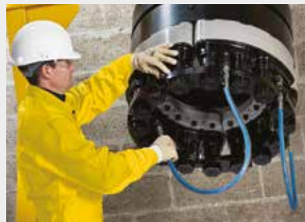
▲ Application de la mise en tension multigoujon
