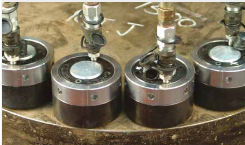
▲ Tensionamento con dadi idraulici.
