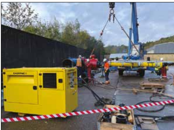
◀ Máquina de roscado en caliente MHT2460-H de Enerpac alimentada por una unidad de potencia de la serie PP44.
