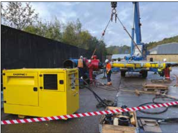
◀ Enerpac MHT2460-H PP44 시리즈 파워팩으로 구동되는 핫 태핑 머신.
