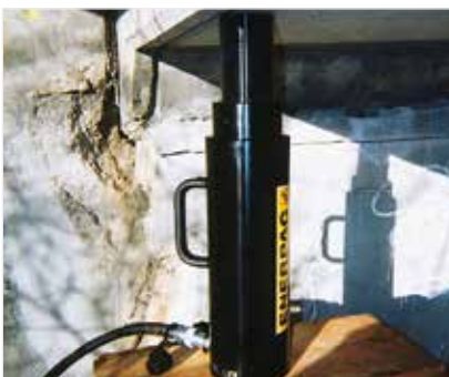
◀ Cilindro portátil RACL1506 con tuerca de seguridad utilizado para el soporte prolongado de la carga durante la inyección de resina epoxy para refuerzo de puentes.
